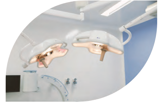
Centro Cirúrgico equipado para procedimentos de média e alta complexidade
